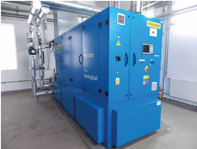
Fot. 1. Agregat kogeneracyjny (K. Sadowska, w [6])
