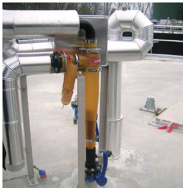
Fot. 1. Widok hydrocyklonu [6]
