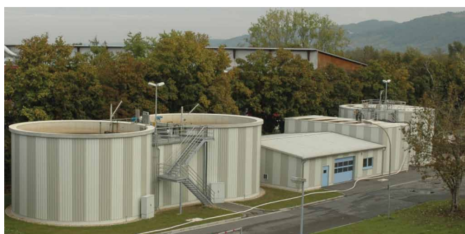
Fot. 4. Heidelberg, Niemcy; 2 reaktory po 550 m 3 [9]
