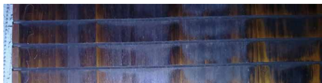
Rys. 20. Ciemne plamy rozmieszczone nieregularnie na wszystkich segmentach komutatora świadczące o iskrzeniu pomiędzy szczotkami a komutatorem
