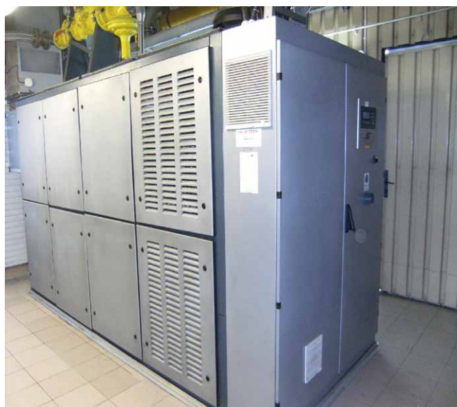
Fot. 3. OŚ Komorowice – agregat kogeneracyjny VISSMANN typ VITOBLOC 200-BM-366/437 o mocy eksploatacyjnej 359 kW
