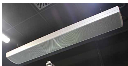
Rys. 1. Pasywna belka chłodząca
