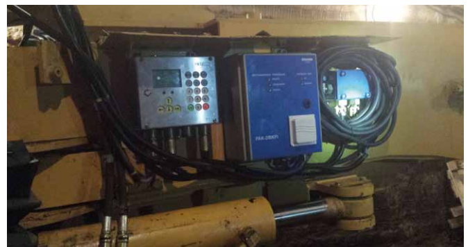
Rys. 9. POP-1 oraz PAK-2 zamontowane na kombajnie chodnikowym KID-220MP
