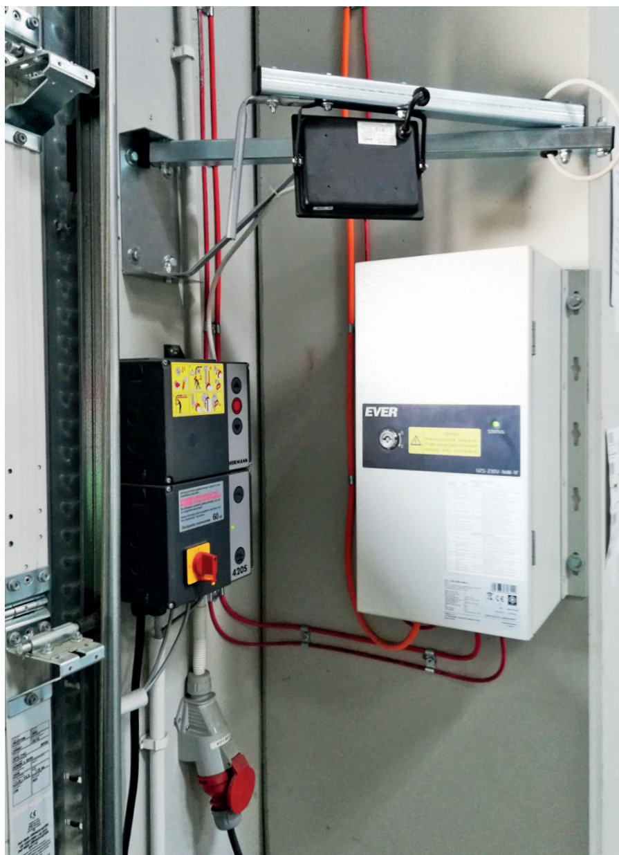
Polski zasilacz UZS-230 V-1 kW-1F wyróżnia się na tle innych dostępnych na rynku niewielką powierzchnią montażową (szer. 290 mm x wys. 500 mm), niską masą urządzenia (tylko 24 kg) oraz możliwością instalacji na powierzchni o niskiej nośności
