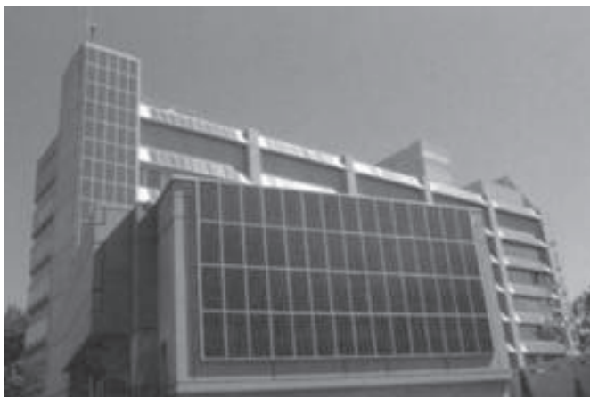
Rys. 4.11. Ambasada USA w Genewie po renowacji z wykorzystaniem modułów fotowoltaicznych [96]
