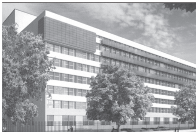
Rys. 4.12. Systemy fotowoltaiczne na fasadzie budynku Wydziału Inżynierii Środowiska Politechniki Warszawskiej [96]
