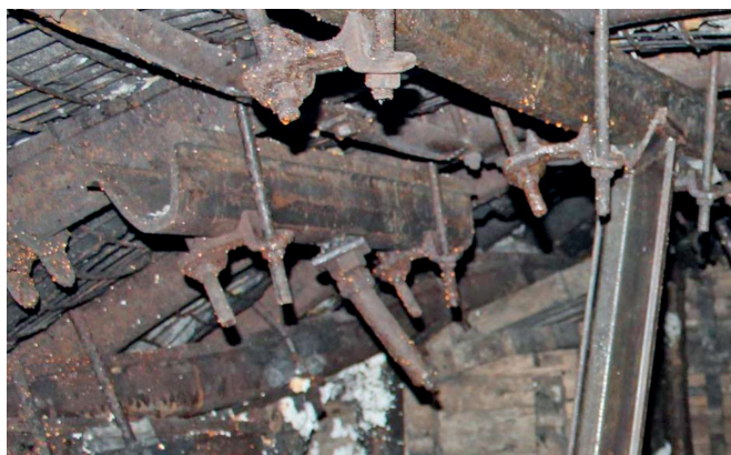
Rys. 13. Kotwa strunowa iniekcyjna zabudowana poprzez podciąg stalowy w chodniku 341-badawczym
