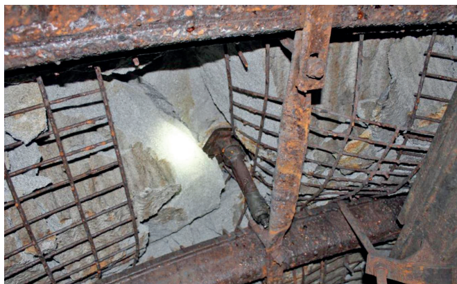
Rys. 11. Kotwa strunowa iniekcyjna zabudowana poprzez podkładkę stalową w chodniku 341-badawczym
