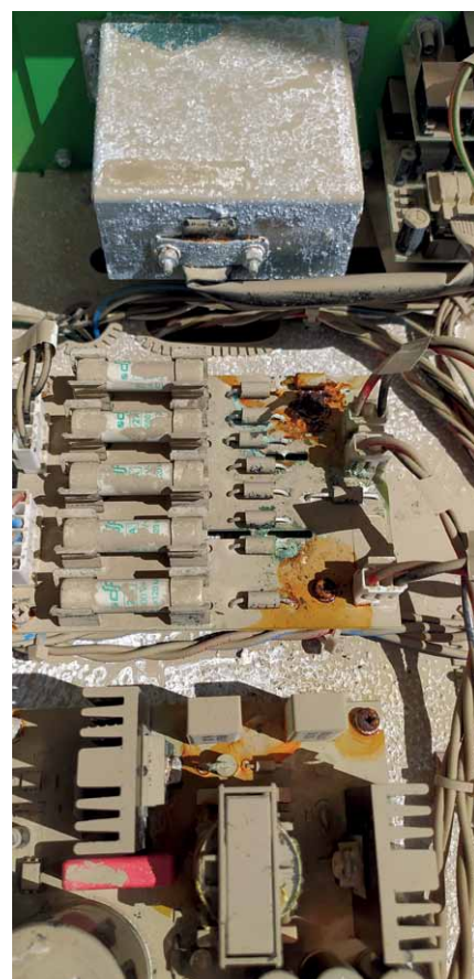
Fot. 1. Przykładowy widok wnętrza zasilacza po zalaniu
