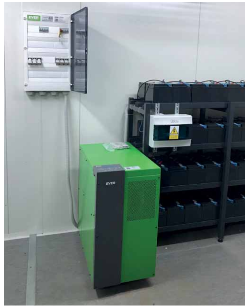
Fot. 2. Przykład instalacji zasilacza z układem bypass
