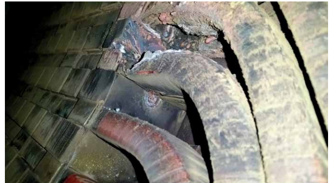
Rys. 5. Uszkodzone cewki uzwojenia stojana
