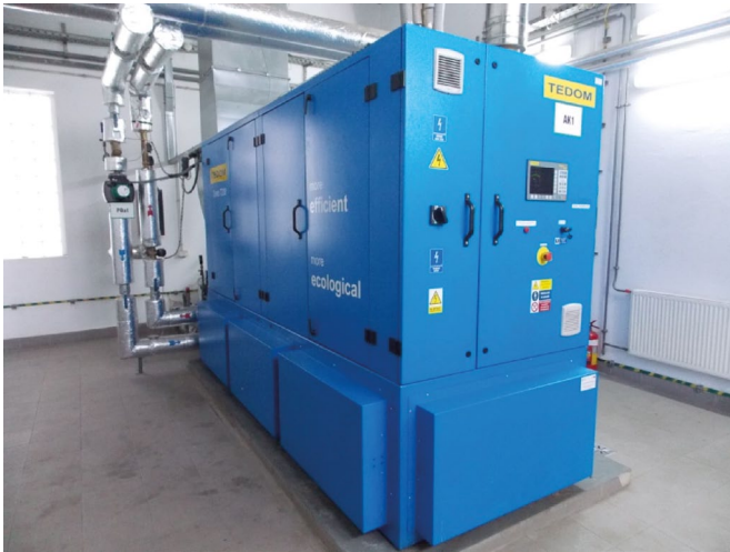
Fot. 1. Agregat kogeneracyjny (K. Sadowska, w [6])
