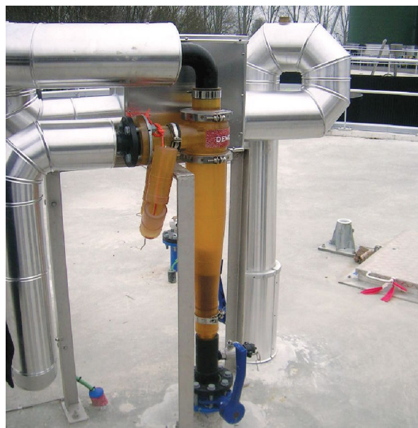
Fot. 1. Widok hydrocyklonu [6]
