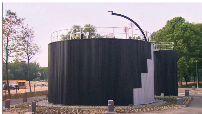
Fot. 6. Nieuwegein, Holandia [6]
