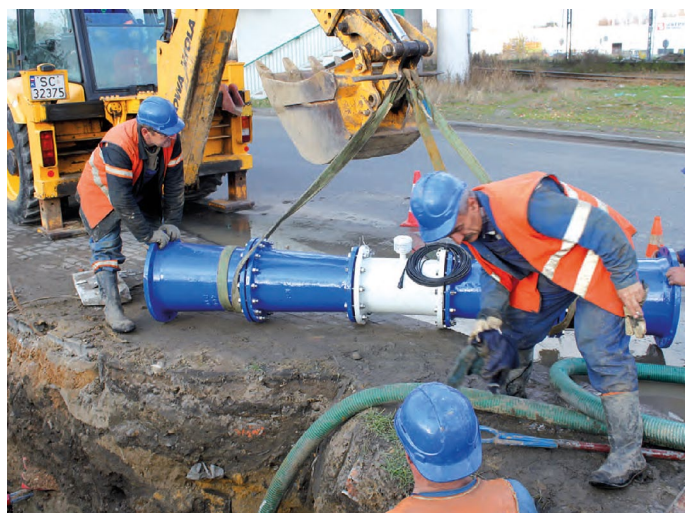
Rys. 3. Montaż przepływomierza kołnierzowego DN400 – Strefa Bór, ul. Jagiellońska
