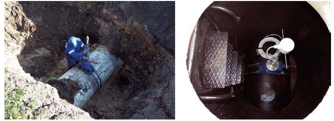
Rys. 8. Montaż punktu pomiarowego z przepływomierzem sztycowym i lekką monolityczną studnią stanowiącą zabudowę przepływomierza – magistrała DN1000
