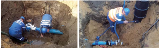
Rys. 7. Montaż punktu pomiarowego z przepływomierzem kołnierzym i monolityczną studnią wodomierzową wykorzystaną do instalacji przetwornika ciśnienia
