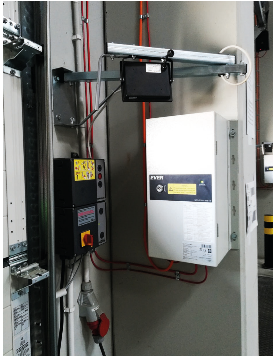
Polski zasilacz UZS-230V-1kW-1F wyróżnia się na tle innych dostępnych na rynku niewielką powierzchnią montażową (szer. 290 mm × wys. 500 mm), niską masą urządzenia (tylko 24 kg) oraz możliwością instalacji na powierzchni o niskiej nośności
