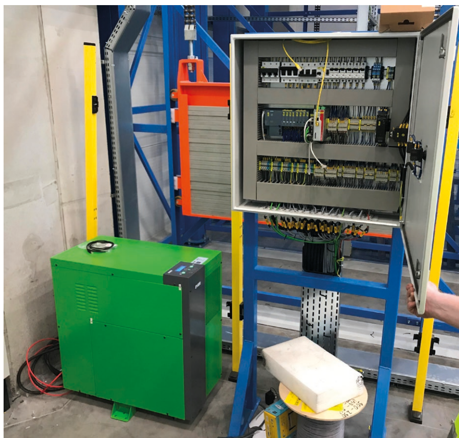
UPS EVER POWERLINE GREEN 33 PRO dzięki możliwości podwójnego przetwarzania energii (separacji energetycznej) umożliwia generowanie na wyjściu jednostki napięcia o parametrach najwyższej jakości VFI-SS-111
