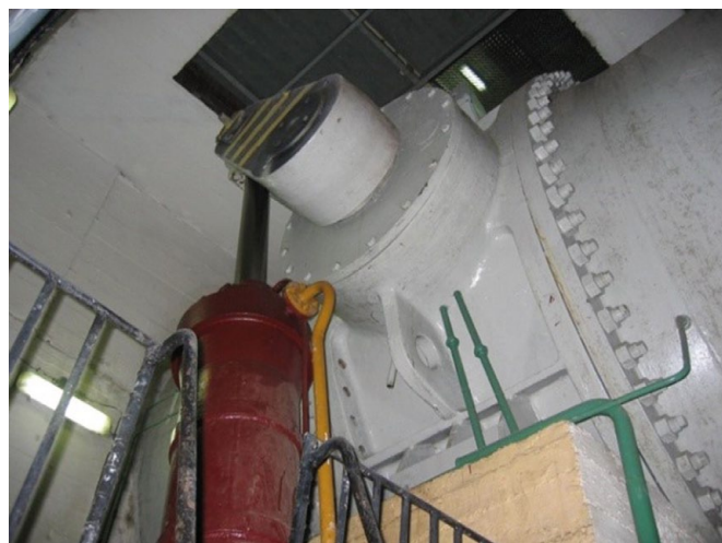
Rys. 2. Hydrauliczny napęd przepustnicy w elektrowni wodnej
