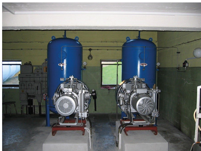
Rys. 4. Zespół sprężarek wysokociśnieniowych pracujących w układzie uzupełniania powietrza w akumulatorach hydraulicznych w elektrowni wodnej
