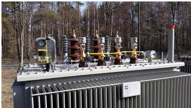
Fot. 1. Przykładowe wyposażenie dławika w wersji hermetycznej
