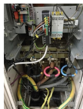
Rys. 2. Zainstalowane elementy systemu Elmodis (przykład)
