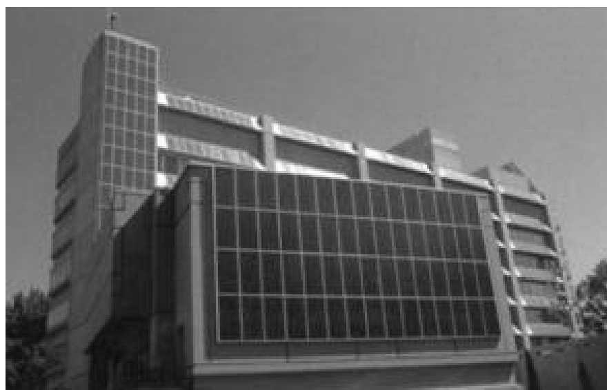
Rys. 4.11. Ambasada USA w Genewie po renowacji z wykorzystaniem modułów fotowoltaicznych
