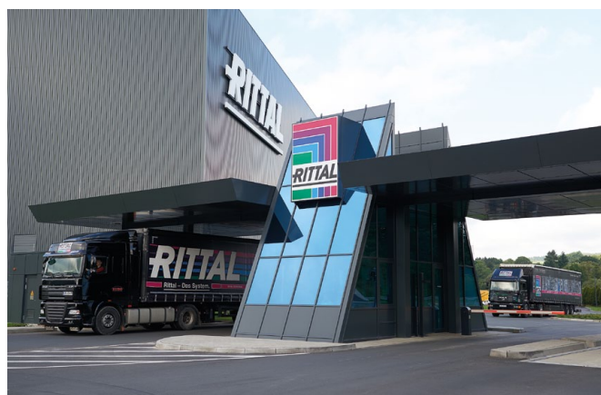
Nowe Globalne Centrum Dystrybucji Rittal w Haiger opuszcza codziennie nawet 80 ciężarówek. GDC dysponuje magazynem wysokiego składowania na 21 500 palet i magazynem drobnych części z miejscem na 25 000 pojemników (Rittal Sp. z o.o.)
