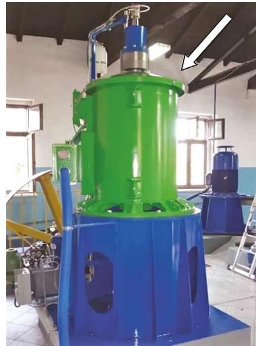
Rys. 17. Bezprzewodniowy zespół prądotwórczy w elektrowni wodnej z ge- neratorem z magnesami trwałymi (kolor zielony - genera- tor)
