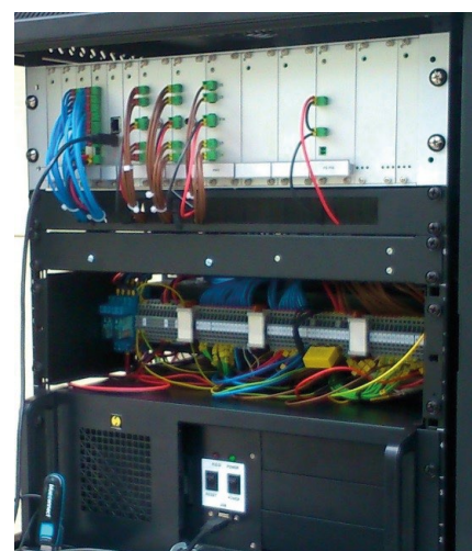
Rys. 8. Przemysłowy sterownik automatyki (PAC) wraz z komputerem przemysłowym
