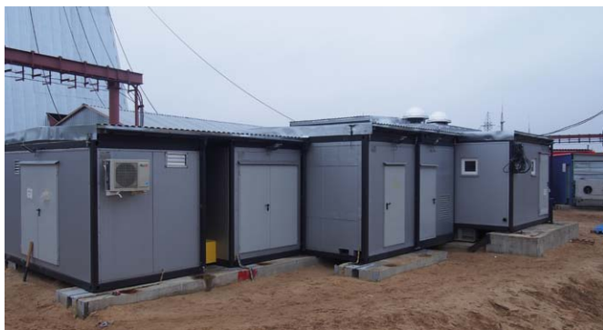
Zabudowa kontenerowa maszyny wyciągowej MPPP-21
