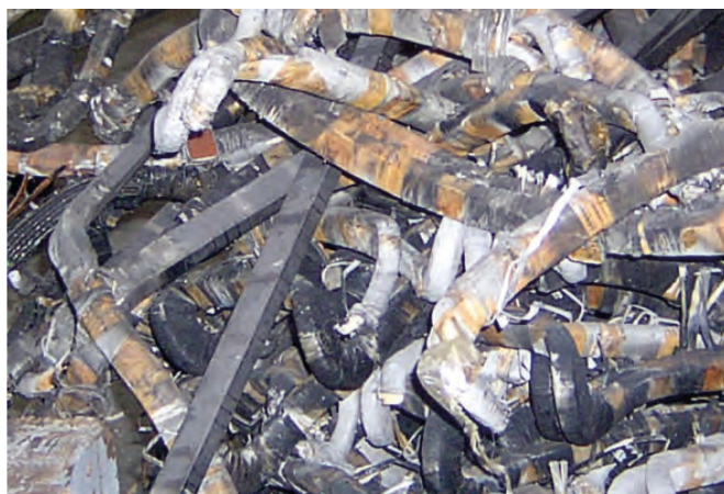
Rys. 1. Co „zostało z uzwojenia” silnika o mocy 4,4 MW po próbie napięciowej
