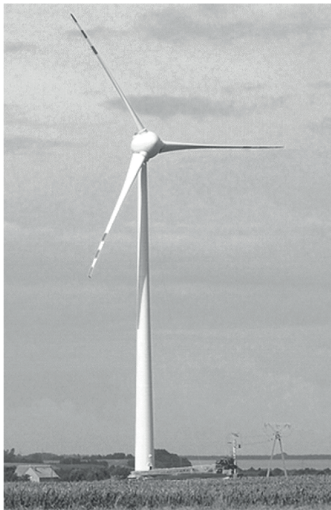
Rys. 4.24. Elektrownia wiatrowa w Pucku [w6]
