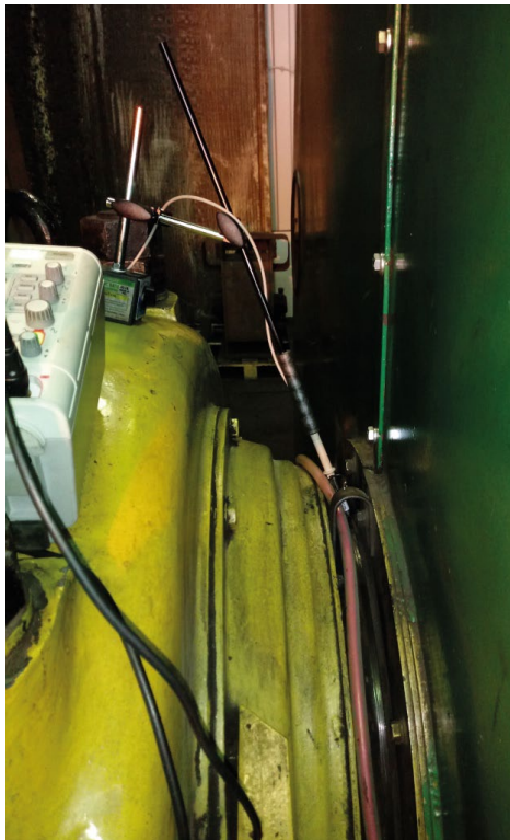
Rys. 5. Pomiar napięcia wałowego oraz prądu łożyskowego przy łożysku Ł2
