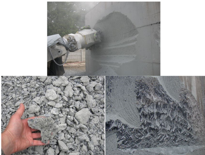
Rys. 24. Widok uziarnienia urobku oraz powierzchni urabianego bloku betonowego
