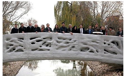
Rys. 9. Wydrukowany w 3D most dla pieszych
