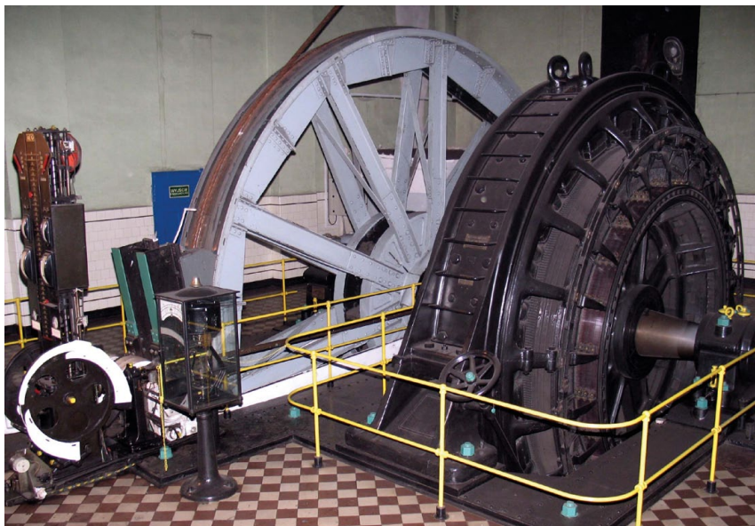
Maszyna wyciągowa AEG na szybie Krakus kopalni Wujek
