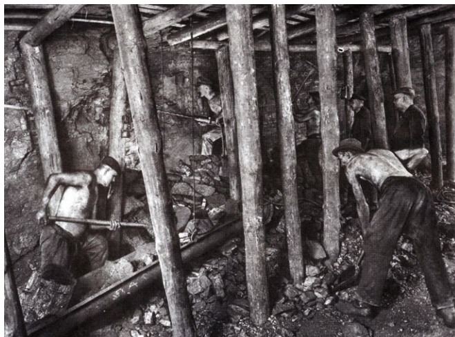
Ładowanie urobku na przenośnik wstrząsowy
