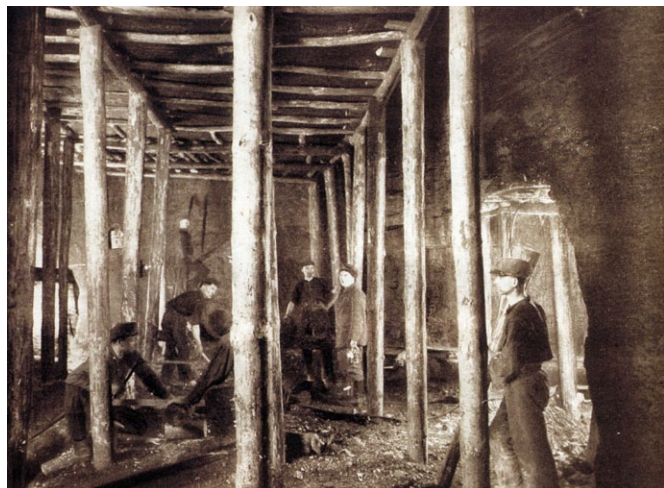
Wykonywanie obudowy drewnianej w wyrobisku filarowym
