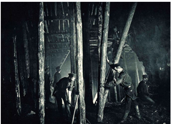
Wykonywanie drewnianej obudowy filaru
