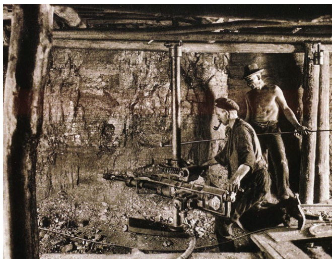
Wykonywanie wrębu pneumatyczną wrębiarką żerdziową
