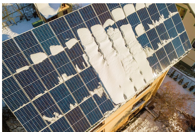
Rys. 4. Praktyczne przykłady sytuacji, w których panele nie są oświetlone równomiernie
