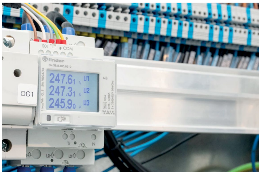
Monitoring napięcia to jedna z 53 zmiennych, które mogą analizować wybrane liczniki 7M
