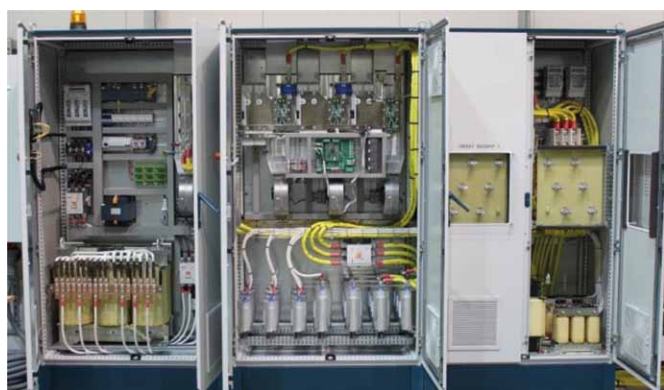
Rys. 7. Stanowisko badawcze do testowania filtrów stosowanych w napędach
