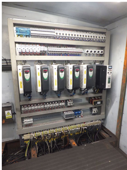
Fot. 2. Napędy Commander SK i Unidrive M w stycznikowni
