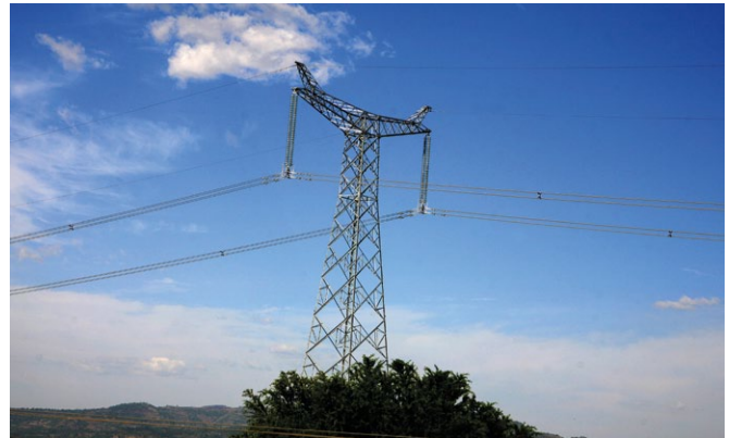
Linia prądu stałego 500 kV na południu Etiopii
