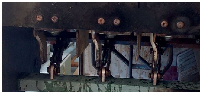
Fot. 1. Ślady działania wysokich temperatur w polu zasilającym dławik
