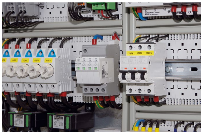
Rys. 3. Dzięki swoim niewielkim rozmiarom i szerokiemu zastosowaniu bez dodatkowego bezpiecznika ogranicznik przepięć Typu 2 może być stosowany dosłownie wszędzie
