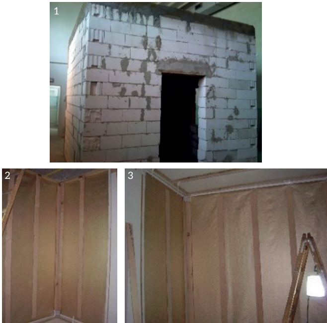
Rys. 3. Pomieszczenie budowlane „domek modelowy” (1) z przykładowym sposobem montażu włókninowych materiałów wewnątrz pomieszczenia (2,3)
