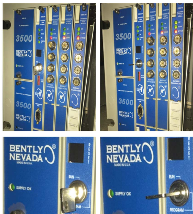
Rys. 5. Przykład fizycznego zabezpieczenia możliwości konfiguracji i rekonfiguracji kasety: z lewej programowanie dozwolone; z prawej możliwość programowania zablokowana
