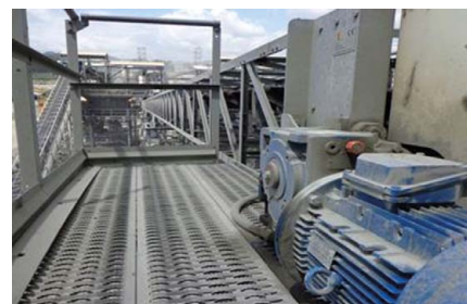
Zakład przeróbki kruszyw, dedykowany na potrzeby rozbudowy Kanału Panamskiego
