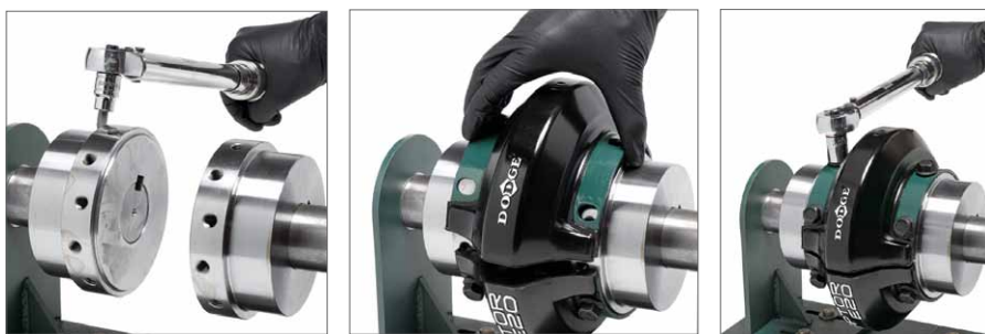
Montaż sprzęgła RAPTOR
