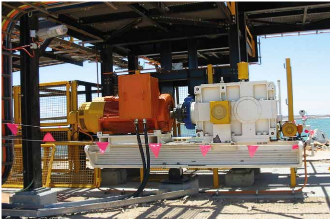
Napęd heavy duty Rossi w zastosowaniu przenośnikowym
