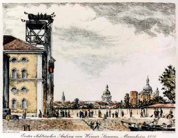
Fot. 13. Pierwsza napędzana silnikiem elektrycznym winda na Wystawie Przemysłowej w Mannheim w roku 1880 Źródło: [17]
