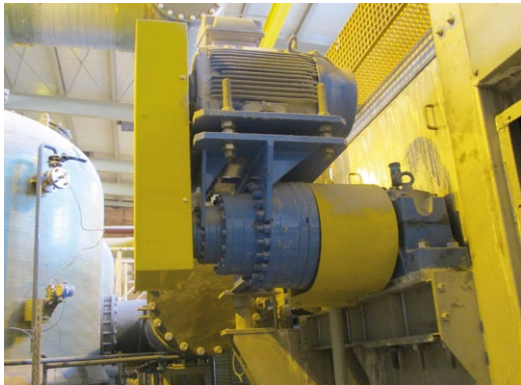
Fot. 4. Napęd planetarny heavy duty zastosowany w przemyśle chemicznym
