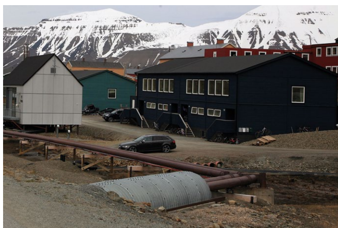
Wykonanie instalacji kablowej w strefie wiecznej zmarzliny
