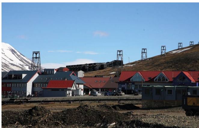
Zachowany fragment kolejki transportującej węgiel do elektrowni Longyearbyen
