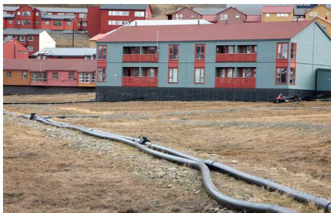
Przyłącza kablowe w rurach ochronnych do domów wybudowanych w strefie wiecznej zmarzliny
