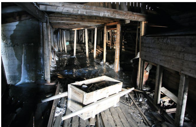
Obudowa wyrobiska kopalni Gruve 2b
