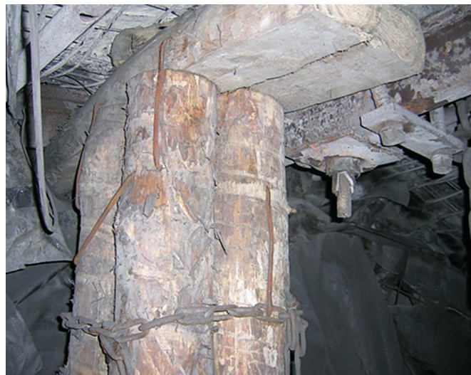
Fot. 2. Widok podciągu przykotwionego kotwami strunowymi
