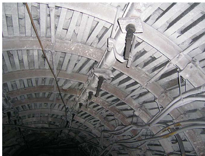
Fot. 1. Widok podciągu przykotwionego kotwami strunowymi
