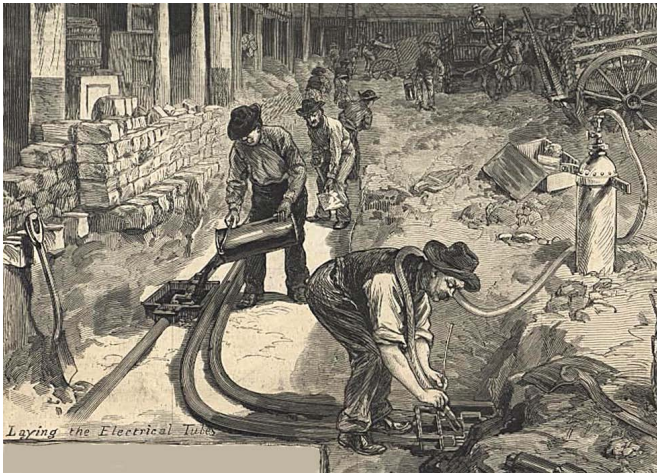
Rys. 9. Robotnicy Edisona układają pierwsze podziemne linie przesyłowe energii elektrycznej [Źródło: Wikipedia]
