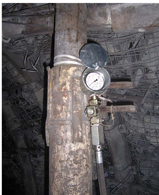
Fot. 5. Stanowisko do pomiaru obciążenia w wyrobisku
