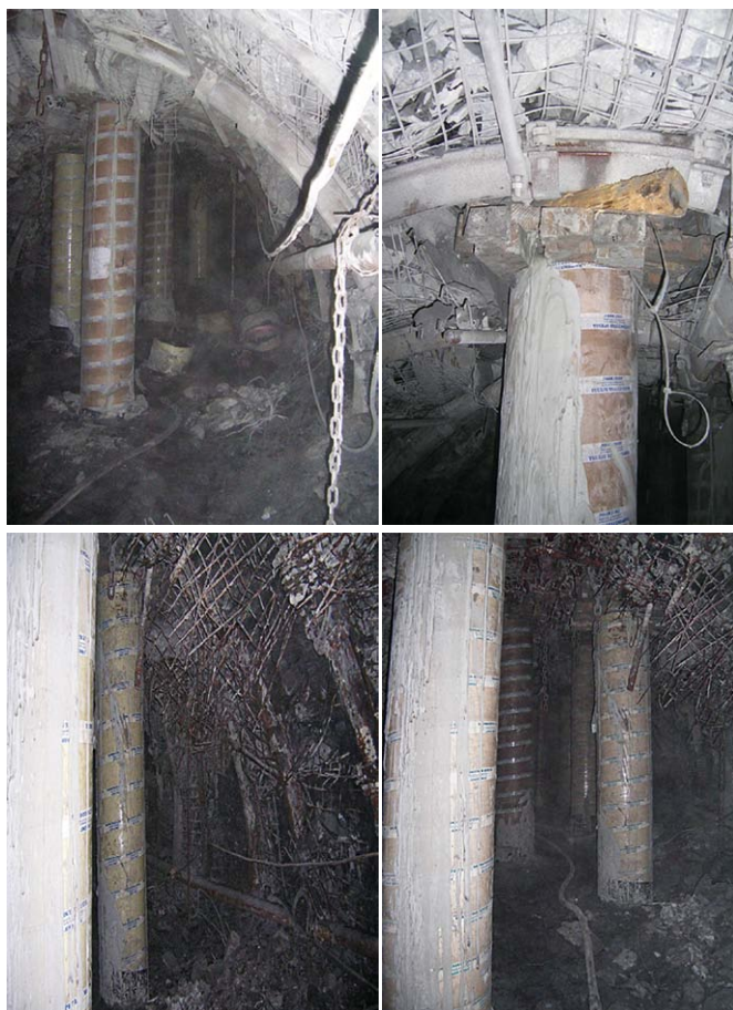
Fot. 4. Widok zabudowanych słupów wypełnionych spoiwem Adibet W-60
