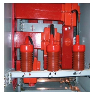
Rys. 7. Podłączenie sprzęgaczy pojemnościowych do uzwojeń stojana badanej maszyny elektrycznej, przykłady [2.95–2.98]
