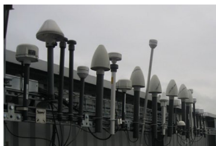
Widok dachu zakładu produkcyjnego zapełnionego antenami GPS
