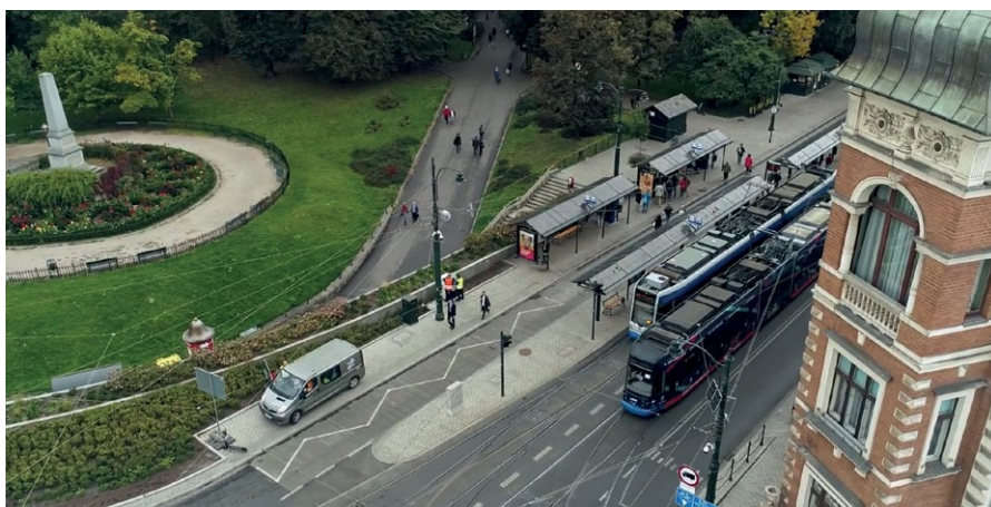
W ostatnich latach ZUE SA współpracowała z firmą Pilz przy realizacji 13 projektów modernizacyjnych w Szczecinie, Krakowie, Wrocławiu, Toruniu i Gorzowie Wielkopolskim
