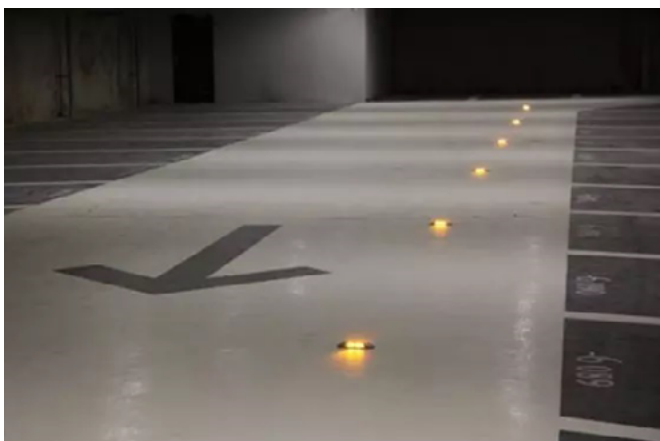
Rys. 1. Ledowe oznaczenie poziome na parkingach, źródło: [8]
