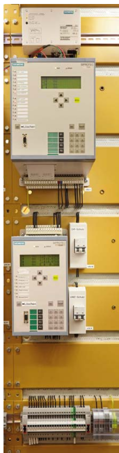
Rys. 4. FAME oszczędza miejsce przez połączenie podstawowych i rezerwowych zabezpieczeń sieci za pomocą jednej listwy wtyków pomiarowych – następnie badania zabezpieczeń prowadzi się za pomocą różnie skonfigurowanych wtyków pomiarowych
