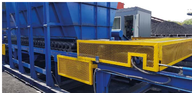
Fot. 4. Platforma serwisowa jednej z taśm mieszalnika
