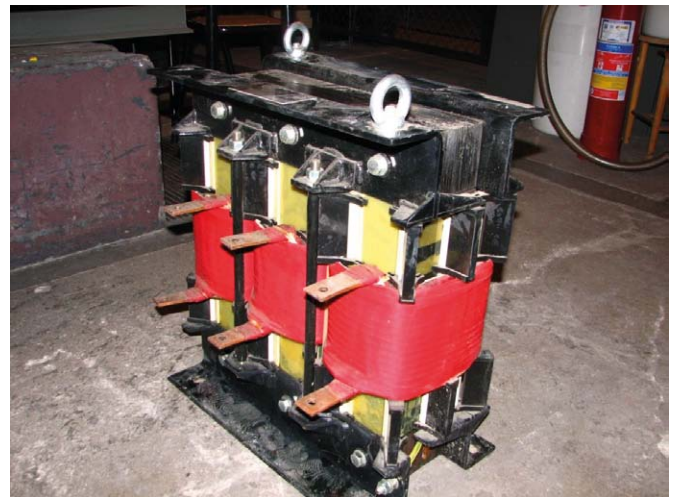
Rys. 4. Nowy dławik trójfazowy
