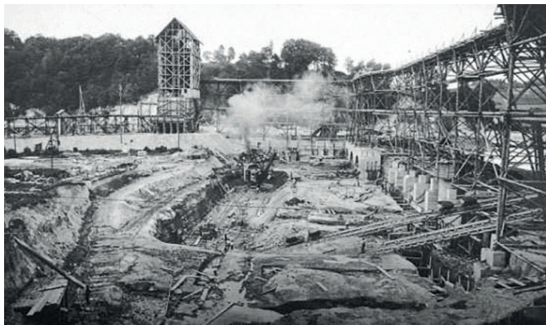
Rys. 3. Elektrownia Mühleberg w trakcie budowy (źródło: wikipedia)
