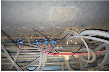
Rys. 5. Przetworniki prądu zamontowane pod pojazdem szynowym
