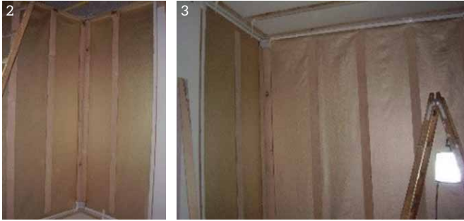
Rys. 3. Pomieszczenie budowlane „domek modelowy” (1) z przykładowym sposobem montażu włókninowych materiałów wewnątrz pomieszczenia (2,3)
