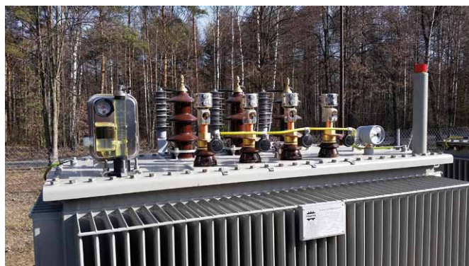
Fot. 1. Przykładowe wyposażenie dławika w wersji hermetycznej
