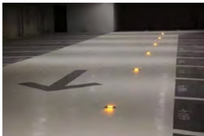
Rys. 1. Ledowe oznaczenie poziome na parkingach, źródło: [8]
