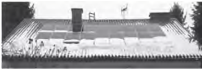
Rys 5.20. Śnieg zalegający na modułach fotowoltaicznych
